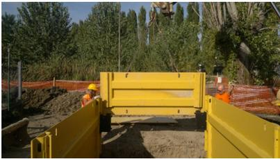
6. Inserire le altre rotaie d'angolo ed inserire l'ultimo pannello di testa (o i Traversoni).
