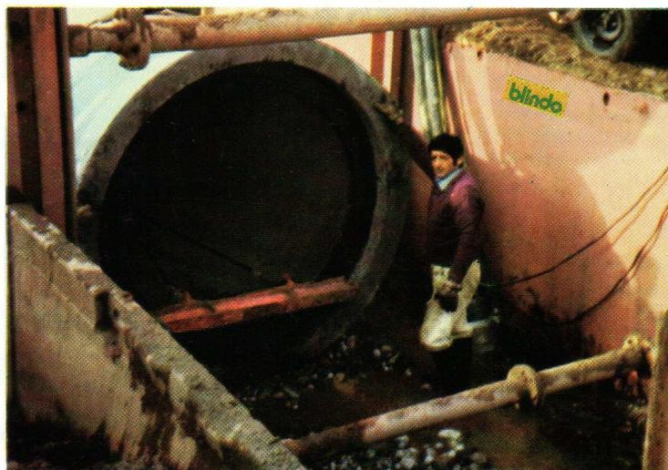
esempio di posizionamento dell'operatore con comando a distanza a pulsantiera
